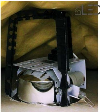
**Écarteurs réglables** d'isolant en rouleau, pour spots LED encastrés.
